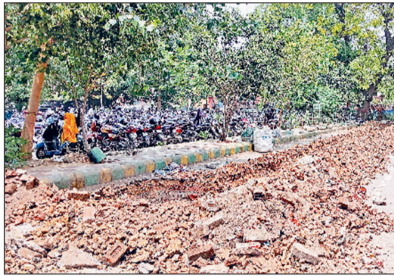
सोनीपत। सीवर लाइन डालने को पाकिंग के पास की गई जमीन की खुदाई।
